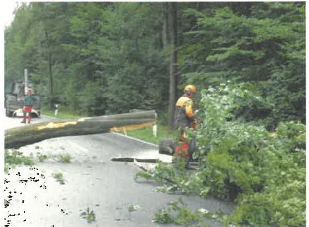
Verkehrssicherungsmaßnahme Bildautor: L. Richter
